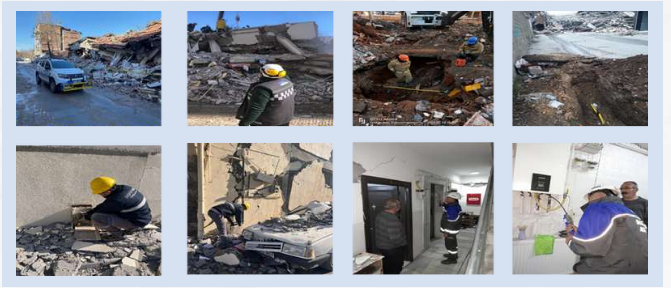
Şekil 21: Doğal gaz dağıtım şirketleri kaçak arama ve körleme çalışmaları.
