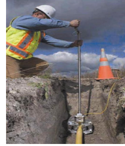
PE hat hasarına vana kapatma boğma işlemi ile müdahale örnekleri
