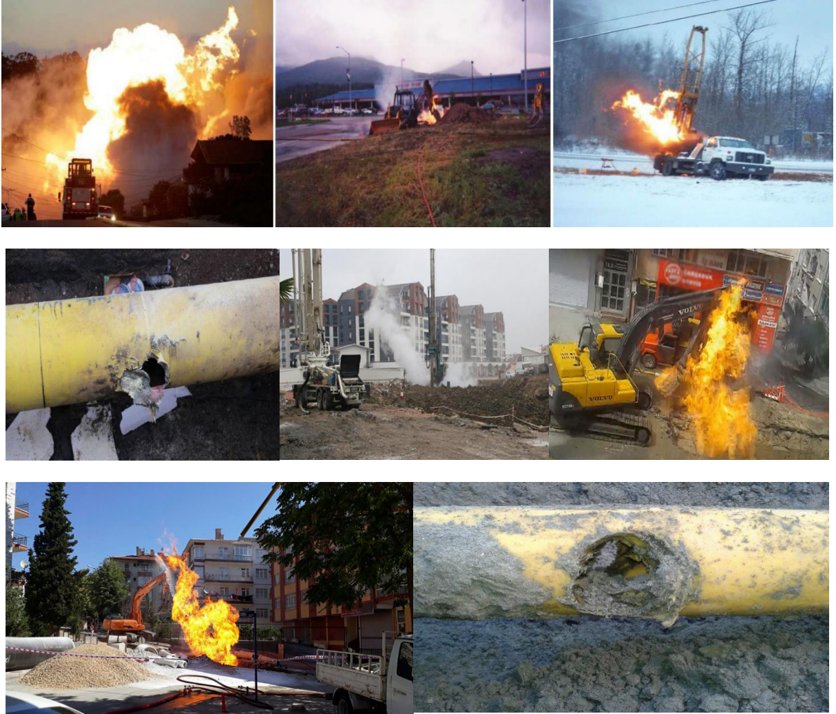
Boru Hattı hasarı örnek olay yeri fotoğrafları
