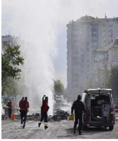
PE hat hasarına vana kapatma boğma işlemi ile müdahale örnekleri
