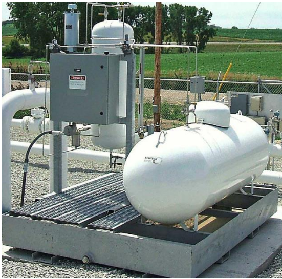
Resim 1: Kokulandırma enjeksiyon sistemi ve koku ölçümü
