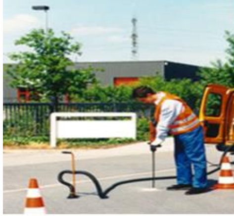
Resim 3: Gaz hattı üzerinden gaz sızıntısı muayene delikleri açma işlemi
